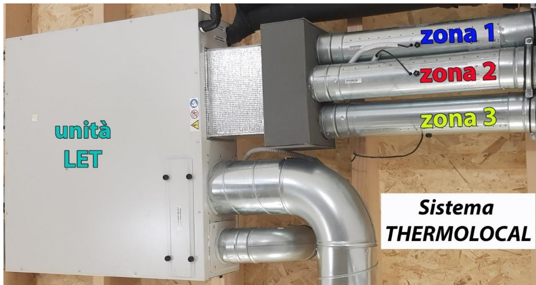
Figura 1 – esempio di installazione con sistema Thermolocal
